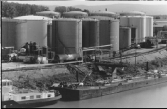
In drei Bereichen des Mannheimer Hafens wird Öl umgeschlagen. Das Bild zeigt Tanklager im Rheinauhafen.
