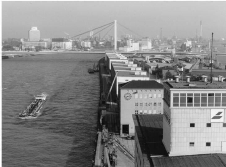
Blick auf die Lagerhallen des 2165 Meter langen Rheinkais.
