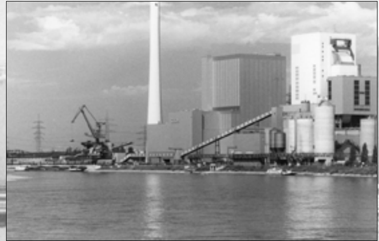
Das Mannheimer Großkraftwerk ist ein bedeutender Umschlagplatz für Kohle. (Rheinauhafen)
